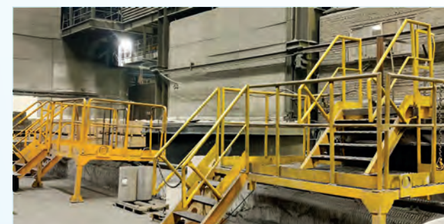
Стационарные площадки с лестницами для спуска в стальковш
